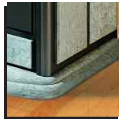
PARTICOLARE: basamento e fianco in pietra ollare
